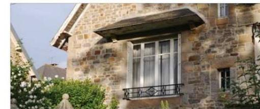
Fig. 2 : garde-corps et menuiseries à partitions d'origine
