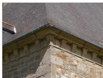
Fig. 2 : modillons en forme de console et corniche du manoir du Roudourou (17<sup>ème</sup> siècle)
