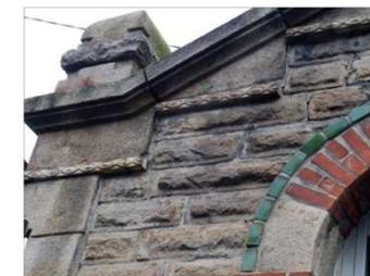
Fig. 3 : arc de brique vernissée sur granit et brique, cordons à motifs en amande, pinacle sur corniche granit, appareil à bossage rustique.
