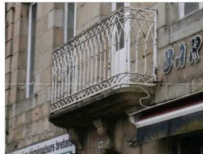
Fig. 2 : Balconnet avec dalle de granit sur consoles, garde-corps en lancettes.
