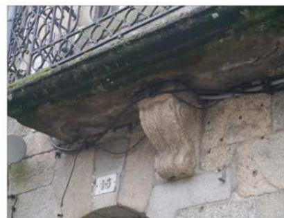
Fig. 1 : Console de balcon à double volute, dalle de balcon moulurée. Granit.
