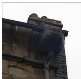
Fig. 1 : corniche en talon sur cordon, gargouille simple en granit, rue Ollivro
