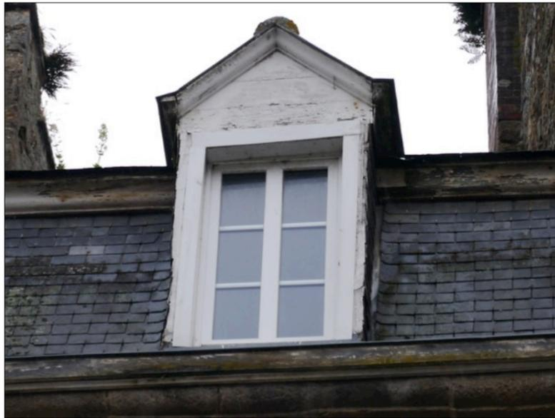
Fig. 332 : lucarne à structure bois, corniche bois des rampants, menuiserie à grands carreaux.
