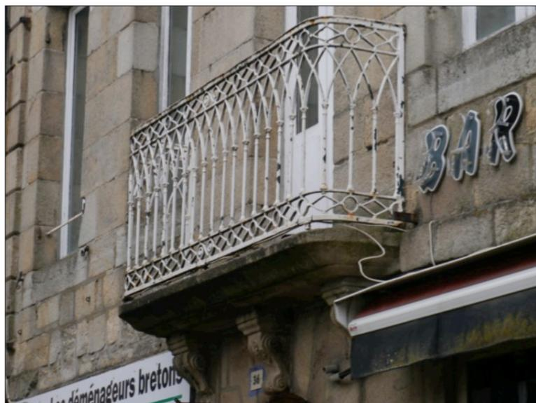
**Fig. 288 : Balconnet avec dalle de granit sur consoles, garde-corps en lancettes.**
