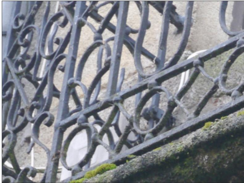
Fig. 307 : Garde-corps en fer forgé (assemblage à billes rivées), 18<sup>ème</sup> siècle.
