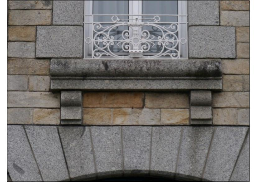
Fig. 309 : appui granit gris sur consoles, garde-corps dans le tableau de la baie, fin 19<sup>ème</sup> siècle.
