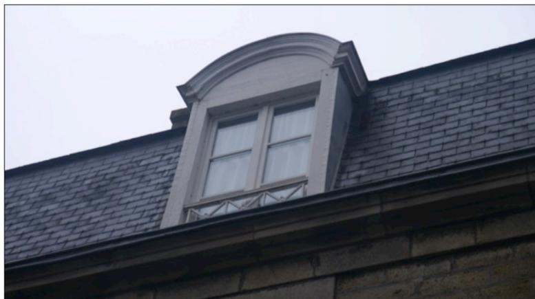
Fig. 334 : lucarne à structure bois, corniche bois sur fronton circulaire, menuiserie à grands carreaux.
