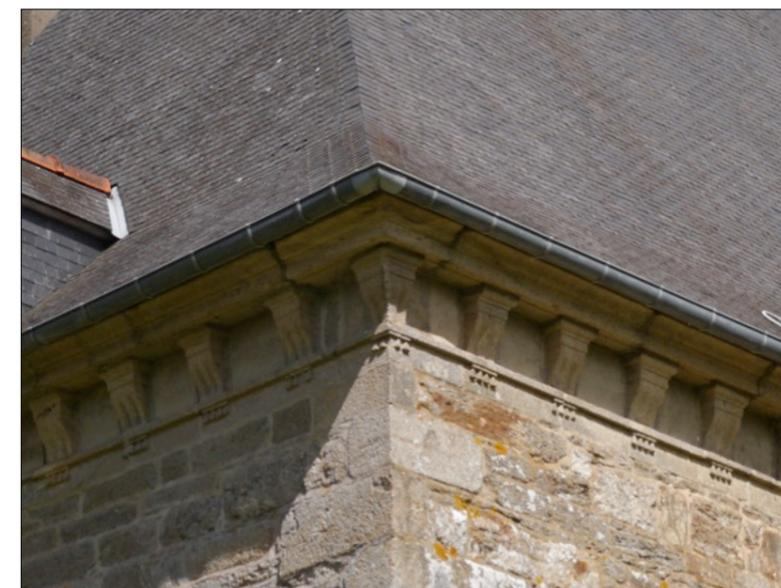
Fig. 317 : modillons en forme de console et corniche du manoir du Roudourou (17<sup>ème</sup> siècle)
