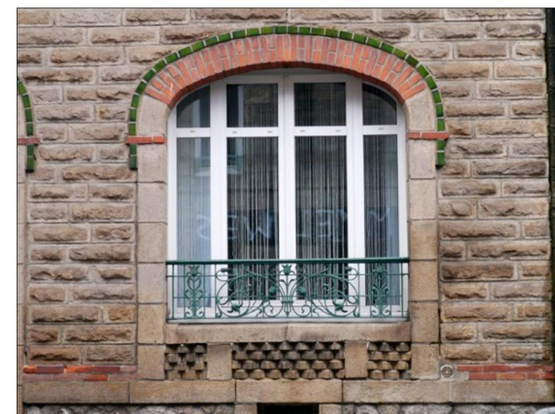
Fig. 329 : effet de relief sur cette allège traitée avec des briques ou pierres posées à 45°.
