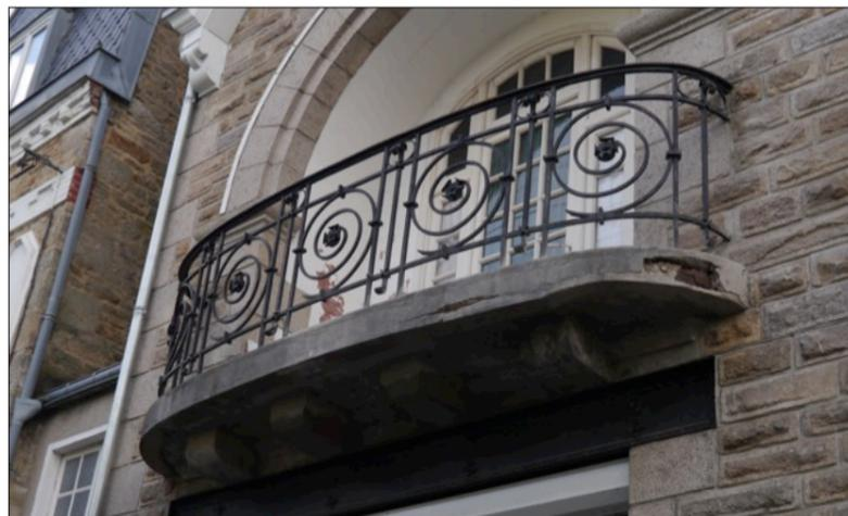
Fig. 311 : garde-corps en fer forgé, motif de spirales en panneaux, début 20<sup>ème</sup> siècle.
