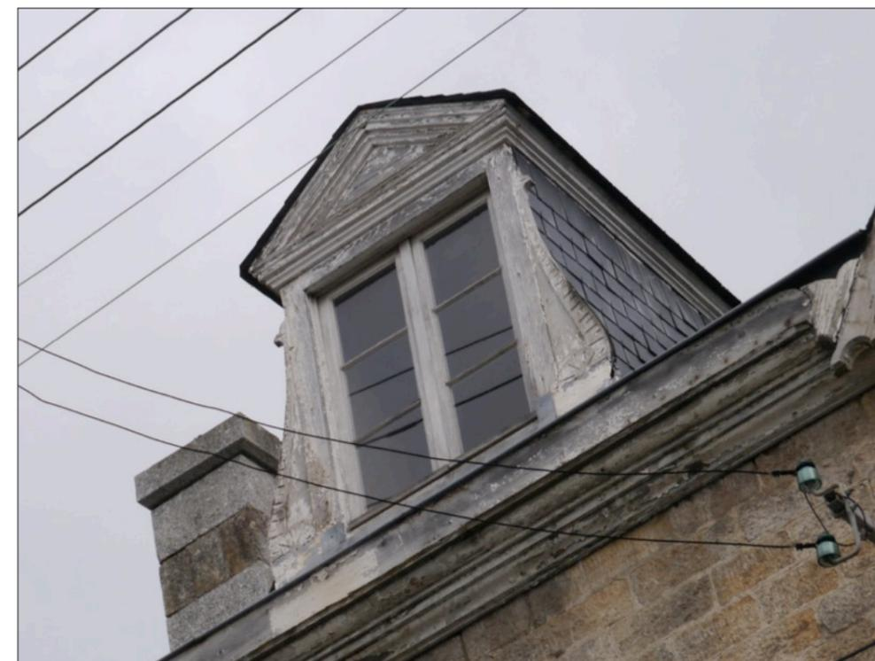
**Fig. 330 : une interprétation 19<sup>e</sup> siècle simple en bois plat d'une lucarne à ailerons granit du 18<sup>ème</sup>**
