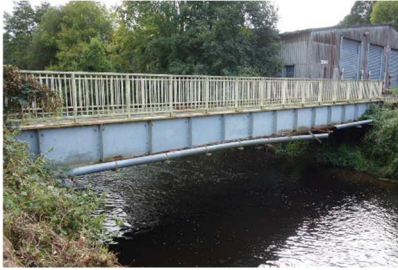
Pont sur le Trieux
