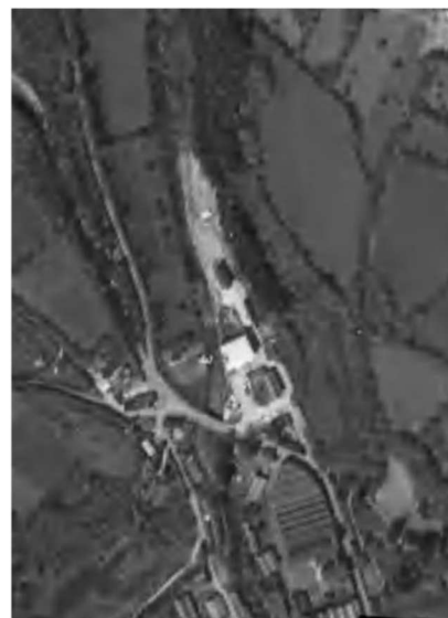
Site totalement artificialisé en 1966 (source : IGN)
