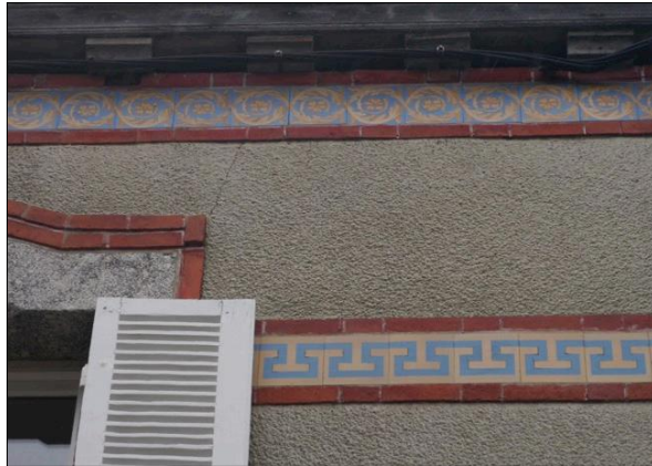
Fig. 320 : linteau de fenêtre en granite, frises : 2 lits de briques et carreaux à motif
