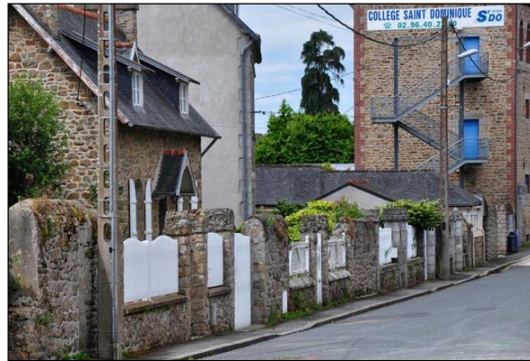
Fig. 10 : Murets à l'alignement rue G al Leclerc
