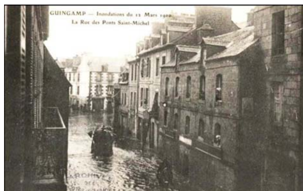
Fig. 45 : Inondations de 1910, Saint-Michel (AD 22, 16 Fi 1538, 1910).
