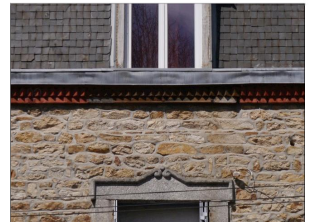
Fig. 319 : corniche en brique, lit à 45° sur bandeau brique en panneresse (fin 19 ème -début 20 ème siècle)
