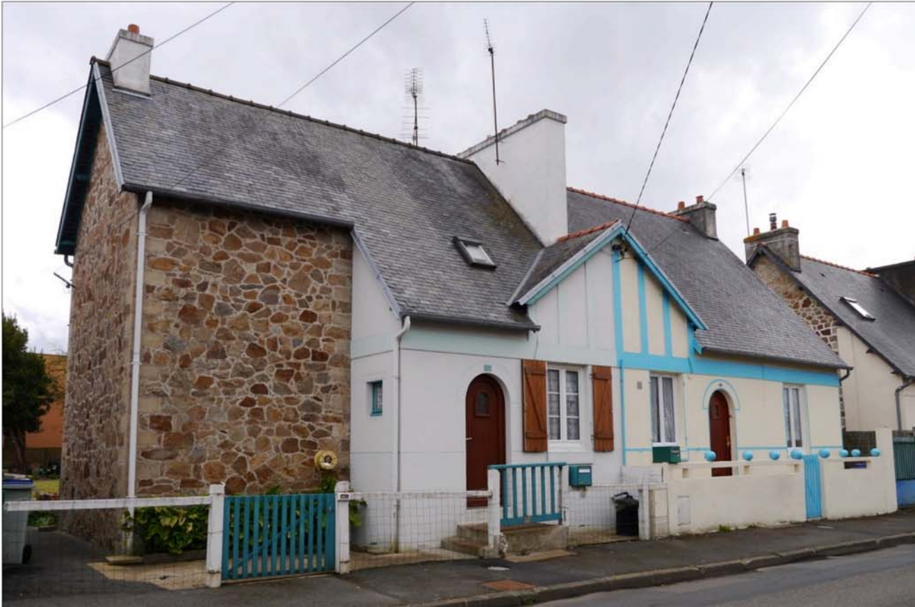
Fig. 68 : Maisons mitoyennes jumelles de l'entre-deux-guerres, rue du 43 ème régiment d'Infanterie, type loi Loucheur.
