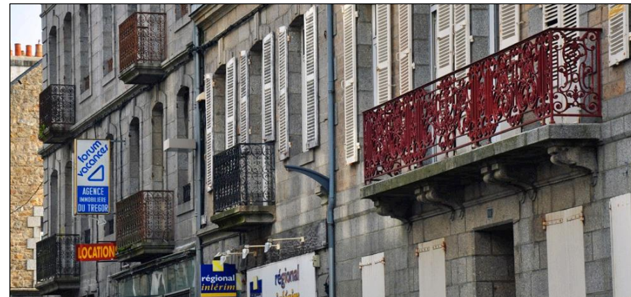
Fig. 231 : Balcons rue des Ponts Saint-Michel
