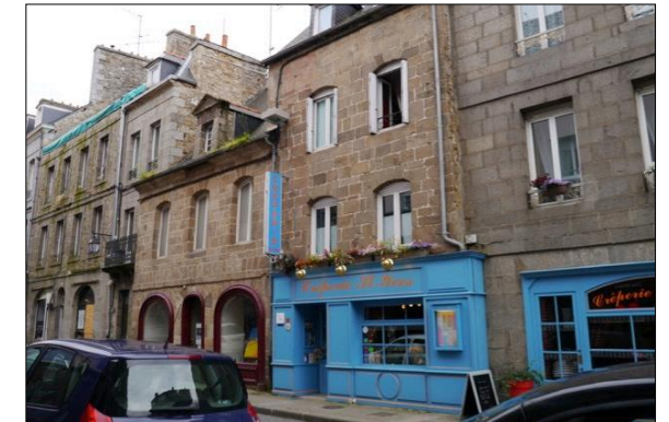
Fig. 244 : 26 et 27 rue Saint-Yves, bâtiments présentant des façades 17-18 ème s. n'ayant pas subi d'alignement.
