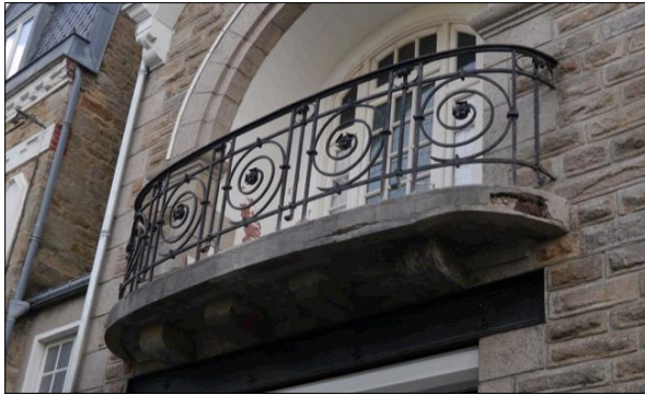
Fig. 311 : garde-corps en fer forgé, motif de spirales en panneaux, début 20 ème siècle.
