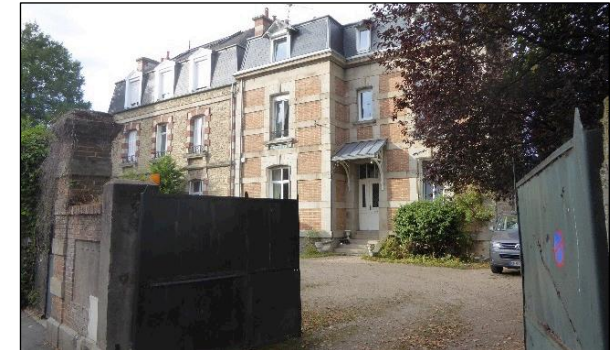
Fig. 130 : L'alignement de grandes villas cossues - marqué par de hauts murs - sur la rive nord de la rue St-Nicolas. Disposées en retrait de la rue sur un parcellaire plus grand et souvent plus massif, elle donne à cette courte section du vieux faubourg des allures de lotissement cossu.
