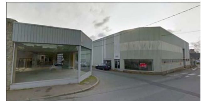
Fig. 71 : Constructions disparates - Rue St-Sauveur
