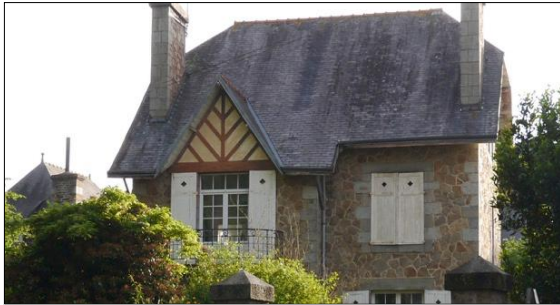
Fig. 324 : pignon avec habillage façon pan de bois en chevrons ou « brin de fougères »
