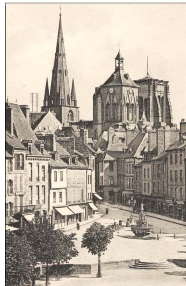
Fig. 33 : La place du Centre (AD 22, 16 Fi 1528, 1928).
