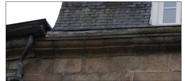
Fig. 285 : Rue Henry Kerfant, corniche à profil en quart de rond sur cavet.
