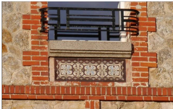
Fig. 321 : appui granite sur allège agrémentée de carreaux à motif, encadrement en brique formant harpe, brique en boutisse sur brique en panneresse formant bandeau.
