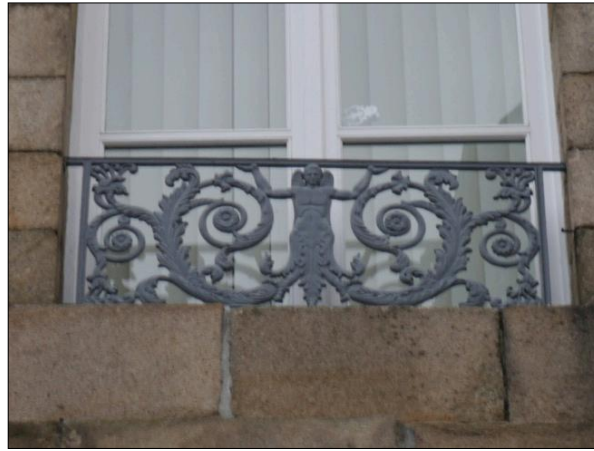
Fig. 308 : Garde-corps de fenêtre du Palais de Justice présentant une figure de la Justice - fonte moulée - fin 19 ème siècle.
