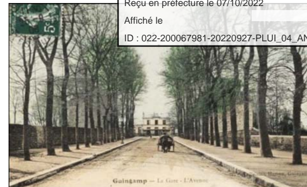
Fig. 32 : Le boulevard de la gare (AD 22, 16 Fi 1572, 1904-1908).
