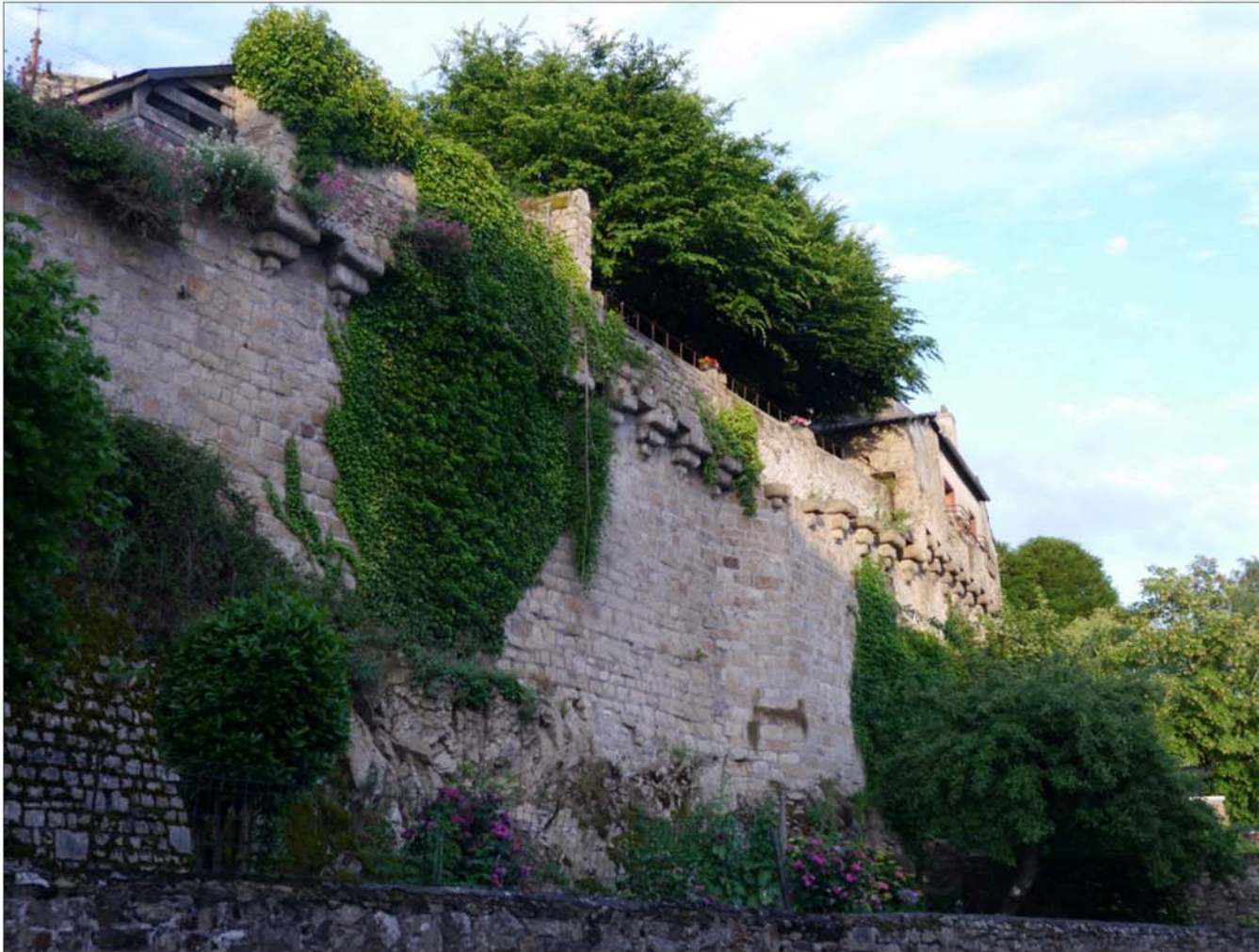
Fig. 50 : Remparts sud-ouest de Guingamp, surplombant la rue du Trotrieux. La qualité de cette portion de rempart construit sur le rocher conservant ses mâchicoulis (corbeaux en quart de rond en forme de pyramides inversées dits mâchicoulis bretons) est intéressante. Elle donne à apprécier le relief naturel du site et laisse le regard imaginer les jardins et petites constructions en balcons surplombant la rue.
