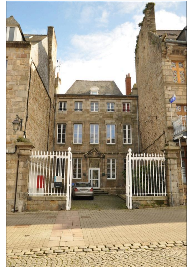
Fig. 223 : Mur bahut place du Centre
