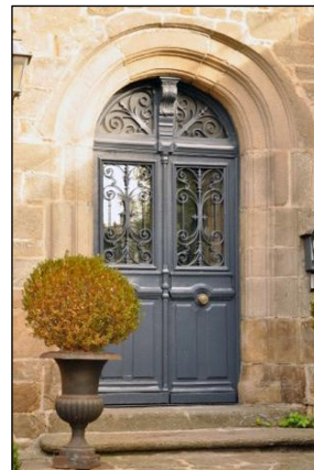
Fig. 230 : Porte rue du Gal de Gaulle
