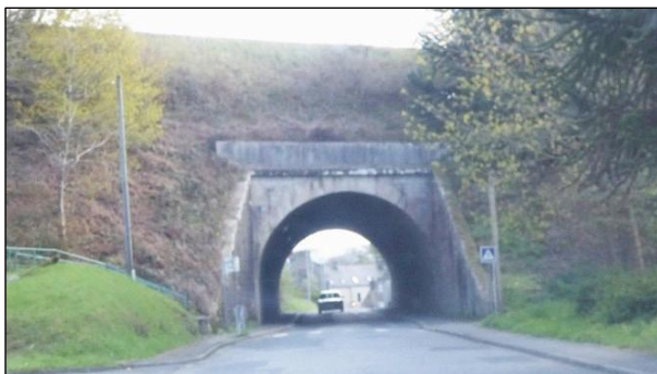
Fig. 174 : L'effet barrière du talus de la voie ferrée, au fond le quartier Sainte-Croix
