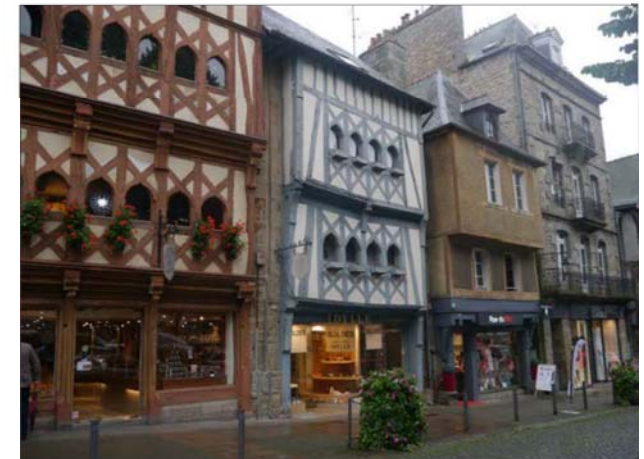
Fig. 66 : Édifice exceptionnel - Maison à pans de bois place du Centre
