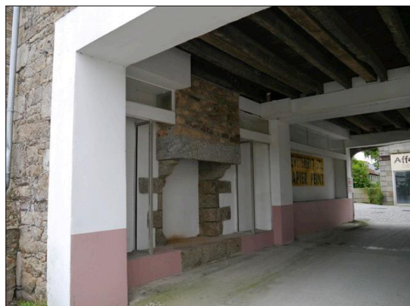
Fig. 268 : 16 rue des Ponts Saint-Michel, porche ouvert dans un bâtiment permettant l'accès au Trotrieux.
