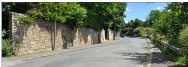
Fig. 78 : Mur structurant - rue Sigismond Ropartz
