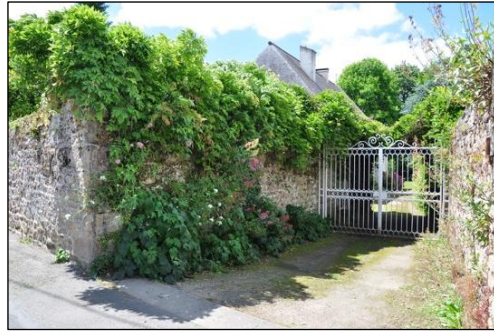
Fig. 217 : Portail rue de Traouzac'h
