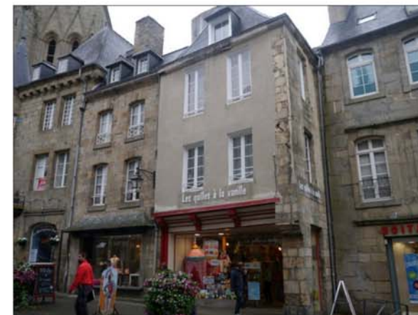
Fig. 279 : 2 rue Notre-Dame, une maison à pans de bois dont les ouvertures ont été agrandies et les étages enduits (tous les pans de bois n'étaient pas destinés à présenter leur structure, parfois de mauvaise qualité).
