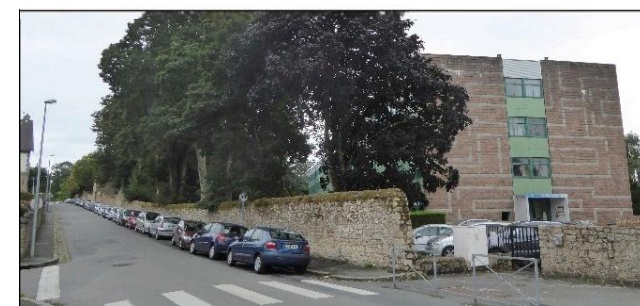
Fig. 194 : Rue A. Le Braz, lycée Pavie
