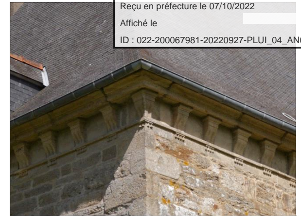
Fig. 317 : modillons en forme de console et corniche du manoir du Roudourou (17 ème siècle)
