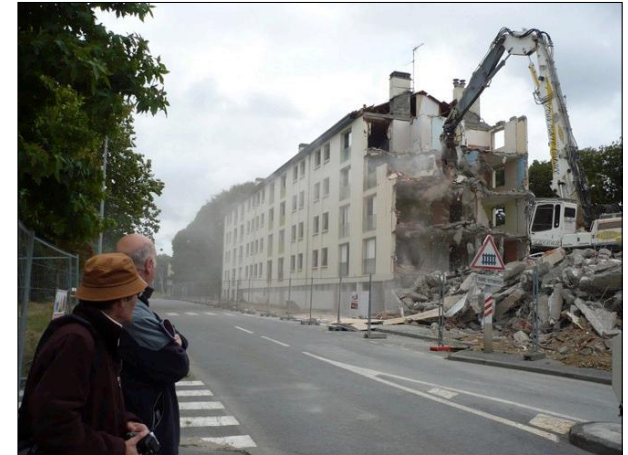
Fig. 72 : Démolition de 81 logements de la cité du Manoir, en 2009. Le renouvellement urbain pose aussi la question de l'obsolescence programmée de l'architecture...
