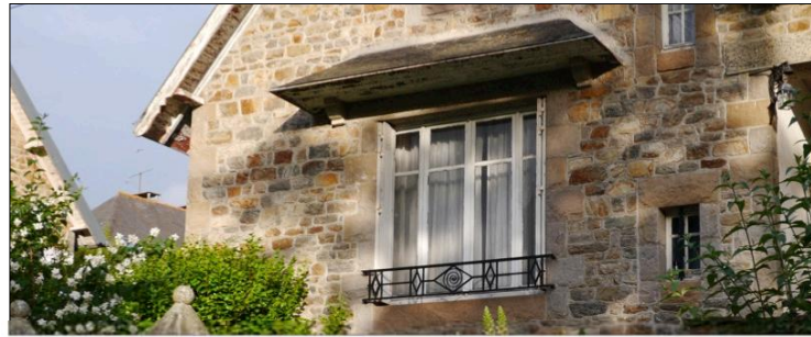
Fig. 325 : garde-corps et menuiseries à partitions d'origine
