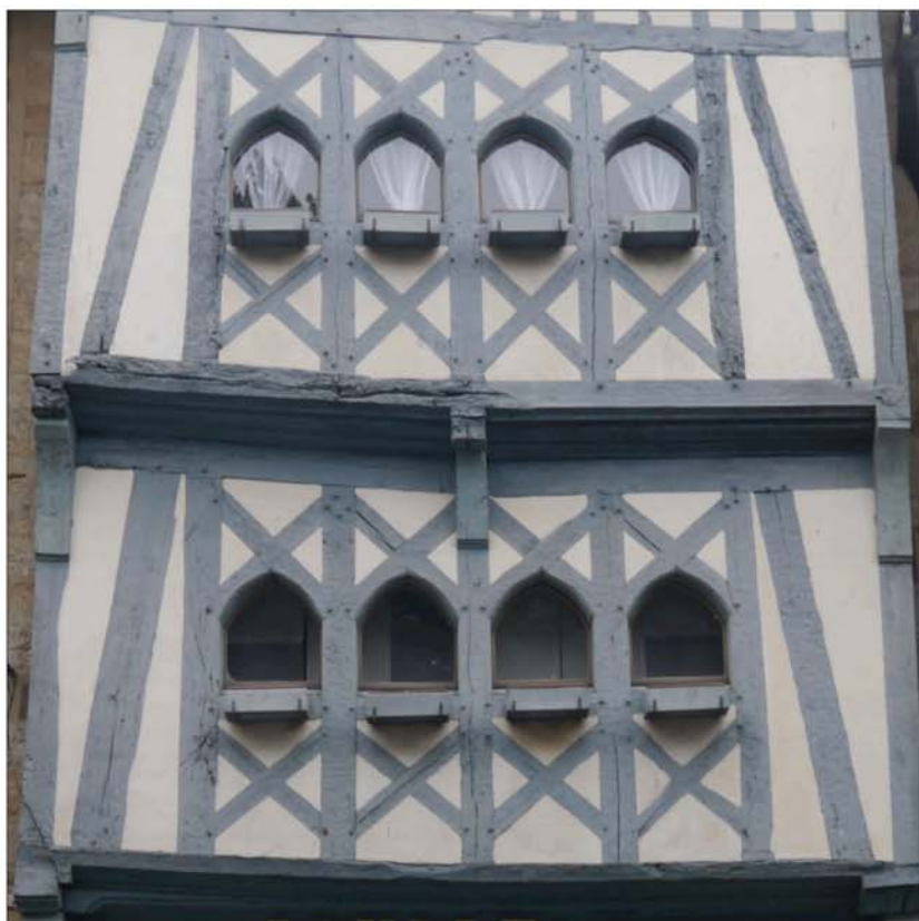
Fig. 276 : ouvertures pratiquées dans les croix du pan de bois, le profil ogival résultant d'un travail des bois (rue Ollivro).
