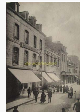
CP ancienne présentant la partition du RDC de l'Hôtel de l'Ouest encore lisibles aujourd'hui, la marquise d'entrée de l'Hôtel, le marquage de faux appareil dans l'enduit
