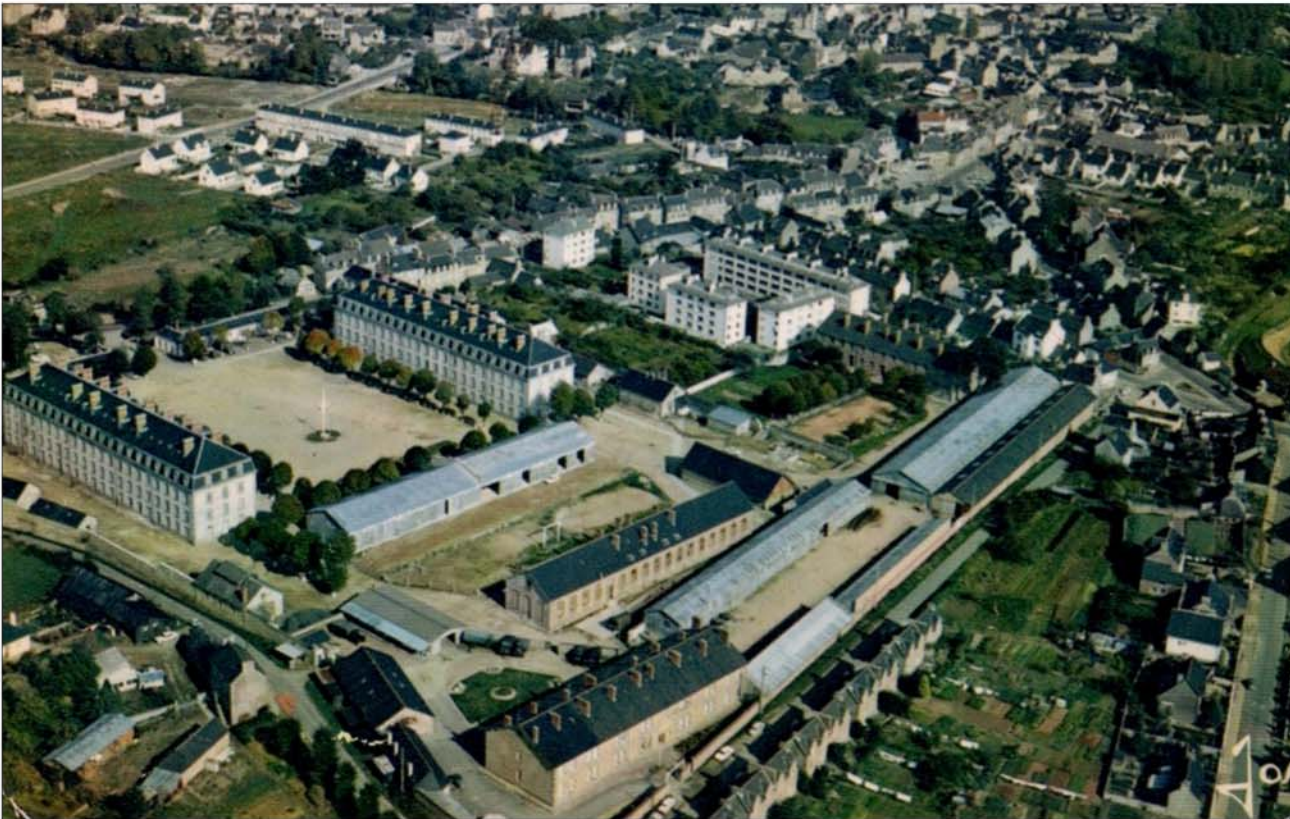
Fig. 64 : Ensemble du 48 e régiment d'Infanterie construit à l'ouest de la ville, à partir de 1876.
