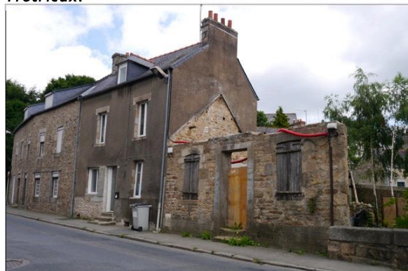
Fig. 269 : bâtiment en ruine au Rustang, dévalorisant l'entrée sud de la ville.
