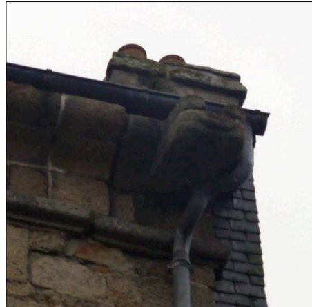
Fig. 315 : corniche en talon sur cordon, gargouille simple en granit, rue Ollivro
