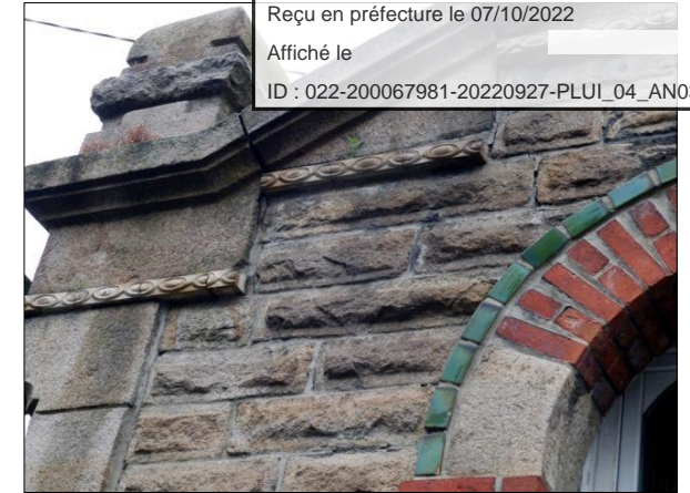
Fig. 327 : arc de brique vernissée sur granit et brique, cordons à motifs en amande, pinacle sur corniche granit, appareil à bossage rustique.
