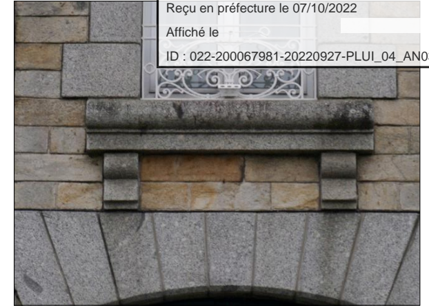
Fig. 309 : appui granit gris sur consoles, garde-corps dans le tableau de la baie, fin 19 ème siècle.
