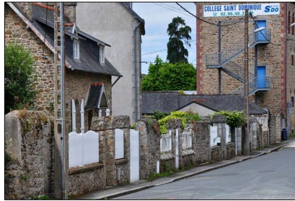
Fig. 200 : Murets à l'alignement rue G al Leclerc
