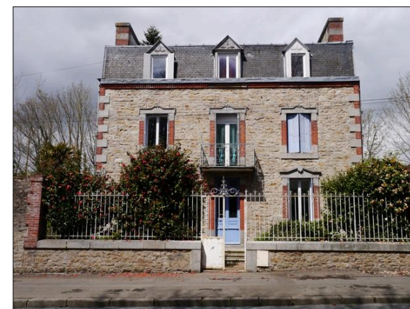
Fig. 300 : rue du Général de Gaulle
