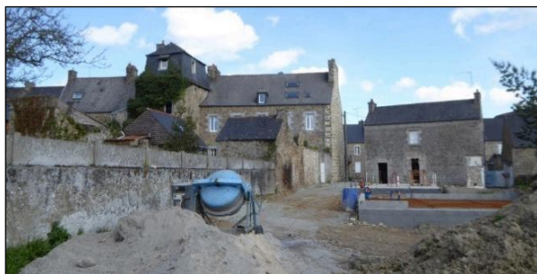
Fig. 141 : Des constructions en cours à l'arrière d'un immeuble
