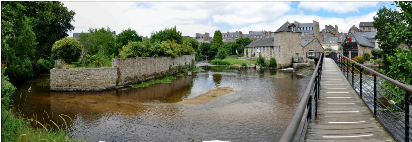
Fig. 33 : Passerelle sur le Trieux vers le centre
