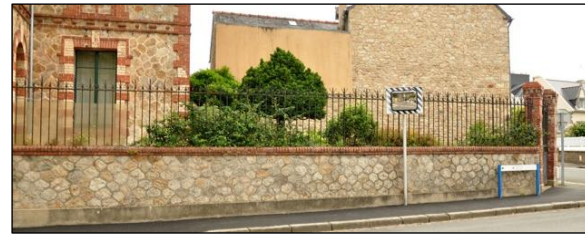
Fig. 214 : Mur bahut à l'angle de la rue des lutins
