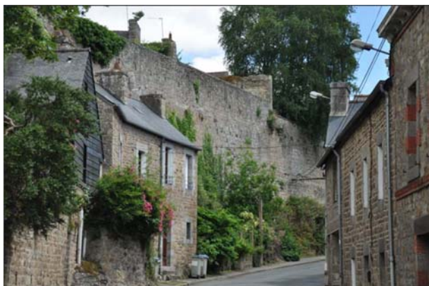
Fig. 79 : Ancien rempart - rue du Grand Trotrieux
