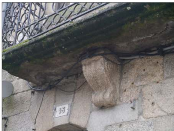
Fig. 287 : Console de balcon à double volute, dalle de balcon moulurée. Granit.
