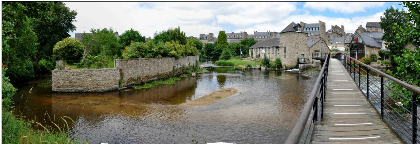
Fig. 96 : Passerelle sur le Trieux vers le centre
