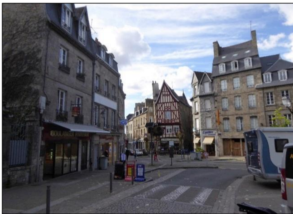
Fig. s13 : Angle Ouest. Effet de choix. Prolongement de l'axe commercial à gauche par la rue St-Yves. Erreur de traitement du sol. Le trottoir devait se prolonger sans élargissement pour amorcer l'inflexion vers la gauche
