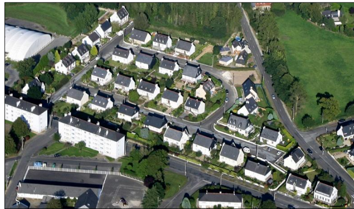
Fig. 29 : Lotissement récent rue Favén
