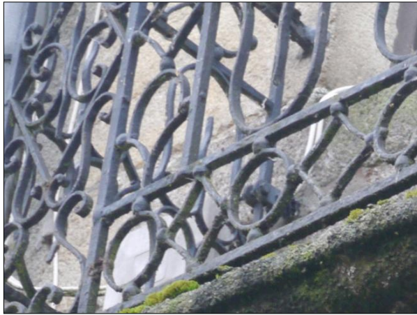
Fig. 307 : Garde-corps en fer forgé (assemblage à billes rivées), 18 ème siècle.
