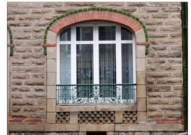
Fig. 329 : effet de relief sur cette allège traitée avec des briques ou pierres posées à 45°.
