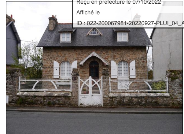
Fig. 302 : rue du Général Leclerc, maison de l'entre-deux-guerres ayant conservé ses portail et clôture, auvent à deux pans et petite lucarne rampante bois.
