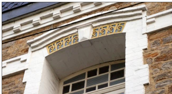
Fig. 322 : habillage de l'arc en brique d'un décor, ensemble des briques peintes en blanc, fenêtre à petits bois et verre coloré.
