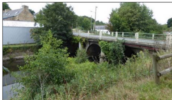
Fig. 108 : Vues encombrées par des bâtiments
