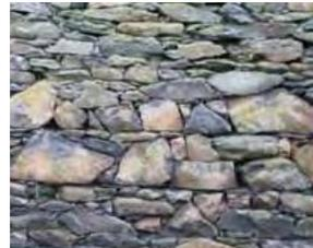
Le mur de moellons : il est constitué de pierres de granit. Comme pour l'habitation, ces murs sont réalisés à double parement avec un remplissage central en pierre concassée. Le chaînage est assuré par un empilement de pierres taillées dans les angles et aussi par le couronnement. Les pierres sont laissées apparentes et restent au même nu que le mur. Les moellons de granit sont montés au mortier de chaux aérienne et sable, joints simplement arasés au montage.
