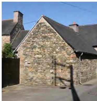
Façades en maçonnerie de moellons, encadrements, chaînages et corniches en pierre de taille.
