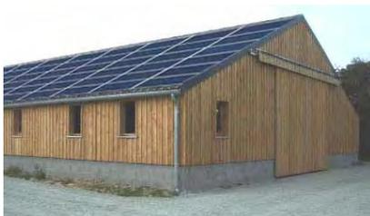
Image 1 : implantation de capteurs sur 100% de la couverture
