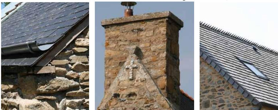
Détails d'éléments traditionnels conservés : couverture, cheminée et décor. Châssis de toit encastré
