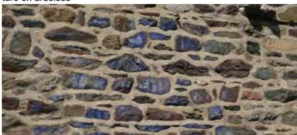
Mur en moellons de granite rejointoyés au mortier de chaux
