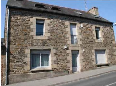
*Châssis de toit non axés sur les autres ouvertures*
