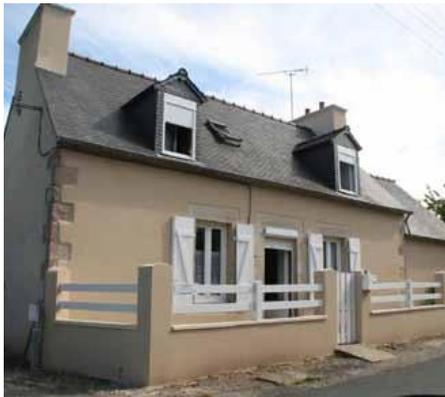
Enduit inadapté, menuiseries et clôture PVC
