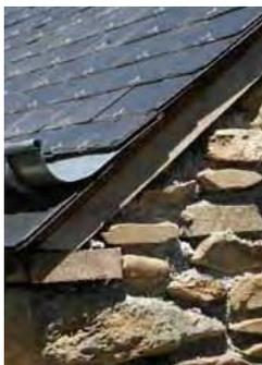
Mur en moellons de granite, charpente en bois, et couverture en ardoises
