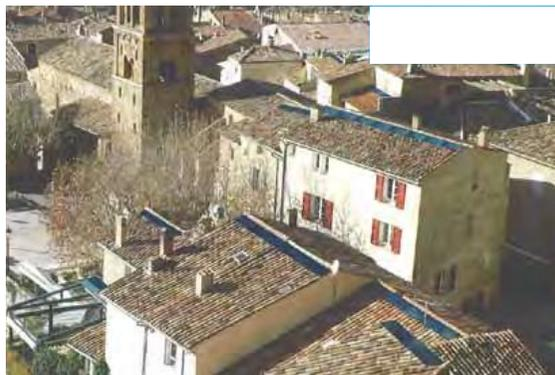
Solution acceptable en bandeaux des panneaux solaires
