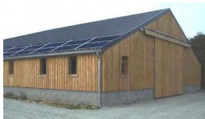
Image 2 : implantation de capteurs en partie basse de la couverture
