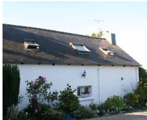
Enduit ciment, baie horizontale, châssis non encastrés et mal positionnés
