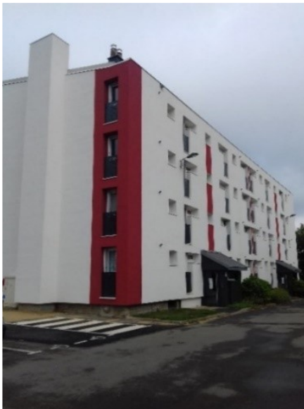
Guingamp : réhabilitation de la résidence Petites salles
